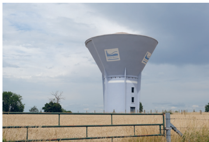
Château d'eau - repère en crête à proximité de Hyds
