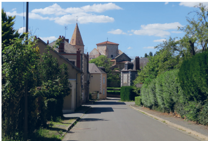
L'église de St-Désiré en point haut, est un grand édifice classé MH, datant du XI e siècle. Il est pourvu d'une tour lanterne à la croisée des transepts et d'un clocher porche construit au XIX e siècle.
