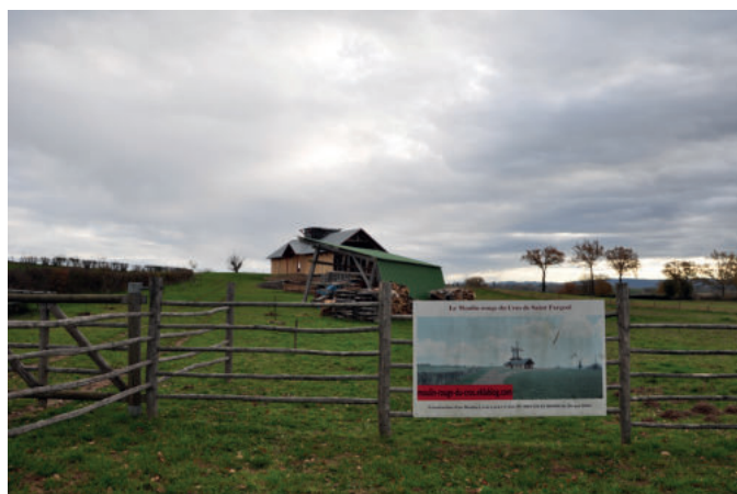
Une initiative privée tirant parti de l'énergie éolienne : Construction d'un moulin à vent à scier le bois à Saint-Fargeol
