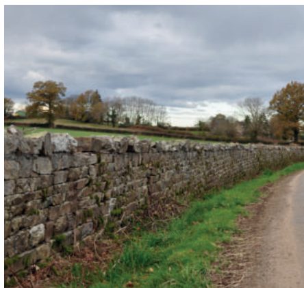
Environs de Saint-Fargeol, muret de pierres sèches accompagnant le bocage, haie disparue
