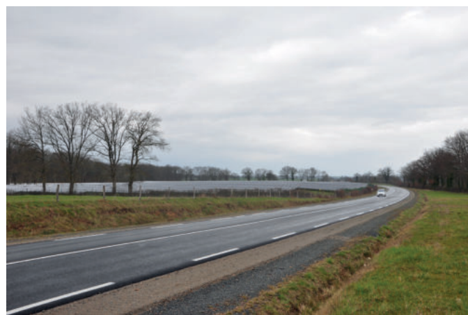
Des panneaux photovoltaïques vers Commentry
