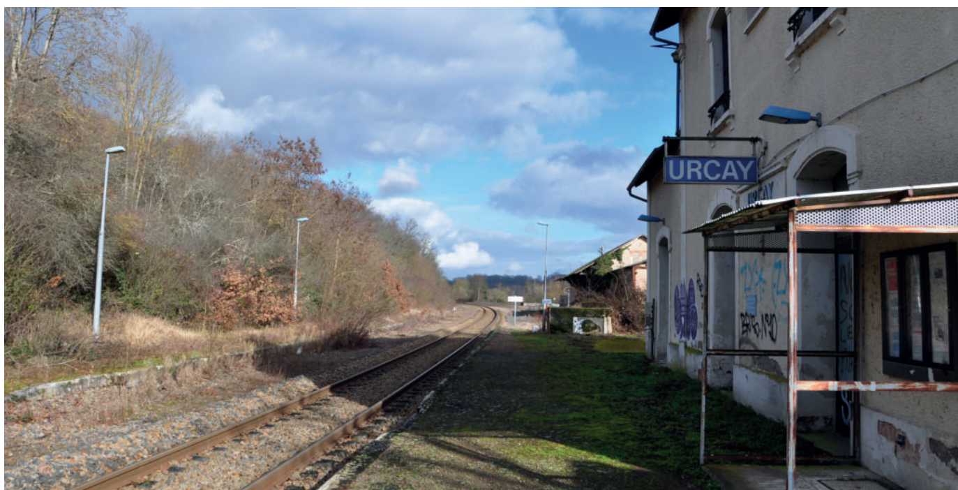
La gare d'Urçay, située à proximité du Canal et du Cher représente un point d'entrée stratégique sur le territoire
