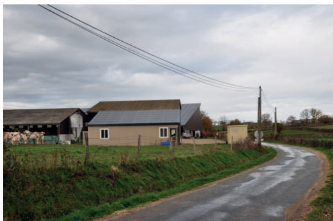
Panneaux photovoltaïque sur une stabulation
