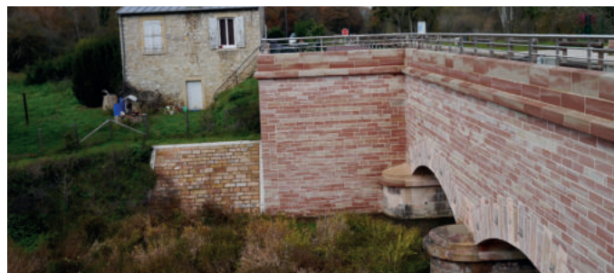
Pont Canal de Vaux
