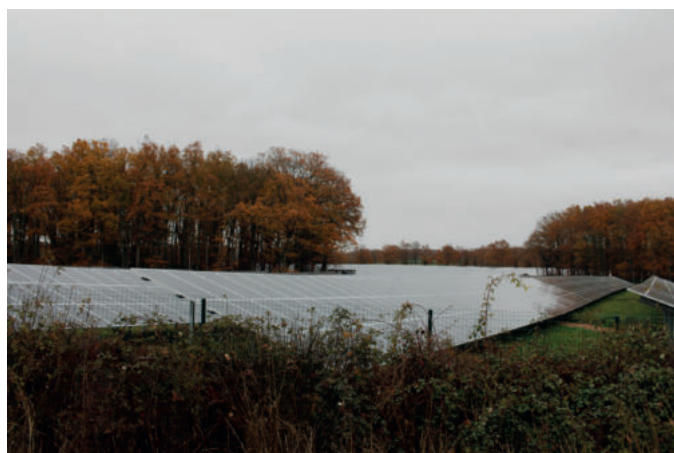
Des panneaux photovoltaïques implantés sur un terrain agricole. La préservation des éléments arborés liés au bocage atténue l'impact
