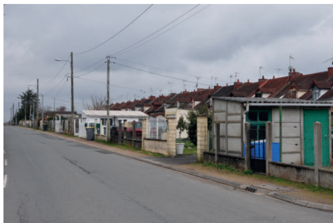
Cité ouvrière des brûlés, Commentry
