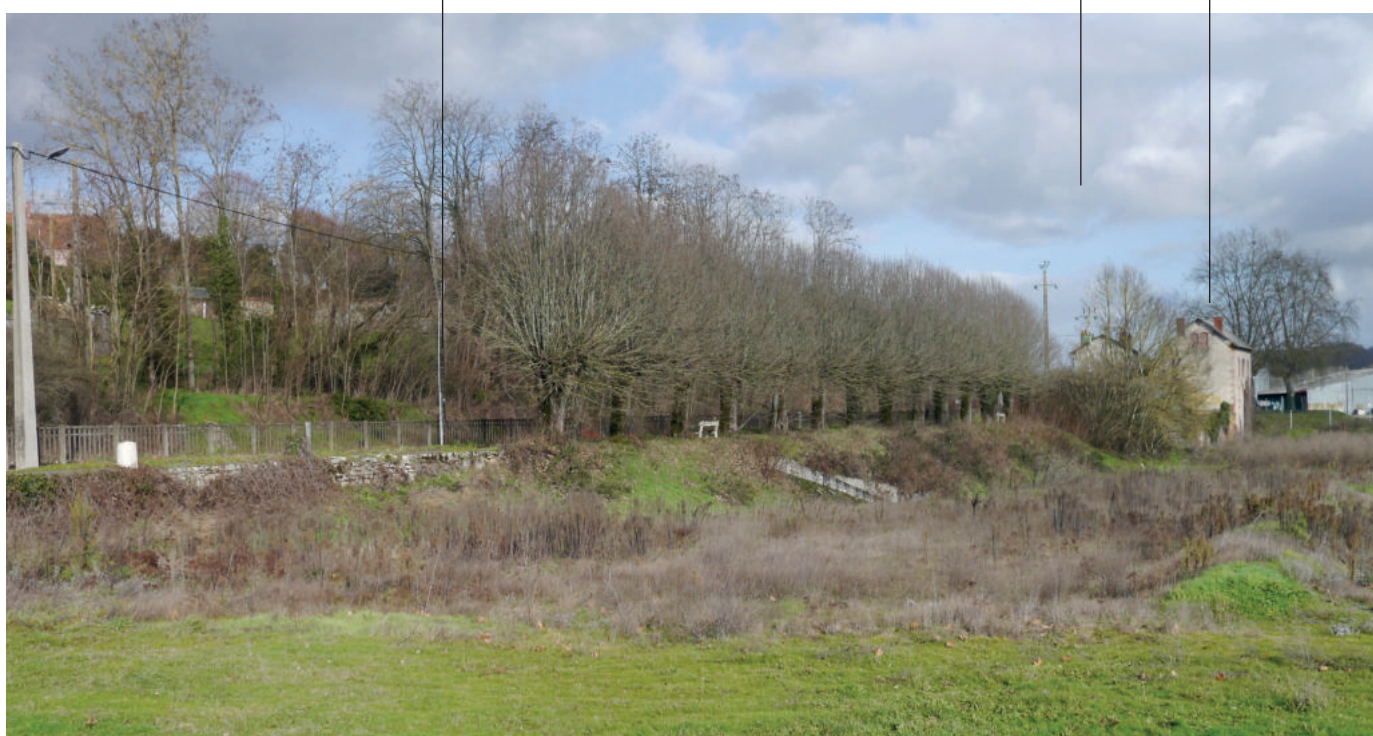
Le secteur de la gare d'Urçay /gare à bateau sur le canal constituait un pôle intermodal avant l'heure.
