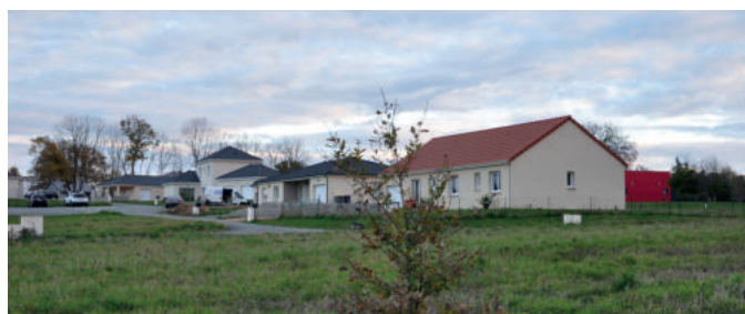
Ces quartiers, souvent désignés sous le terme de «lotissement», sont déconnectés de leur contexte car développés sur eux-même (avec des voies sans issue. Ici la juxtaposition d'architectures sans rapport les unes avec les autres contribue également à amoindrir la qualité de ce nouveau quartier
