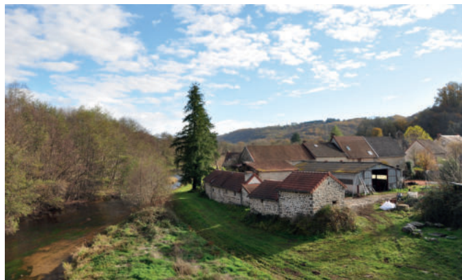
Exemple de hameau rural rénové dans l'esprit des lieux : Chambonchard, au sein de la vallée de la Tartasse
