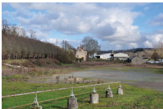
Les perrés ont disparu sous les remblais, seules les balustrades de pierre et d'acier émergeant du sol rappellent le tracé du canal (la Perche/ Urçay).
